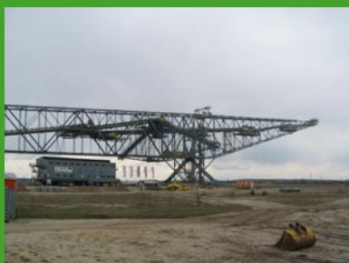
Förderbrücke F 60 Lichterfeld Foto: Gisa Ruland
