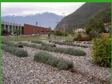
Bezirkskläranlage Meran Foto: Peter Risto
