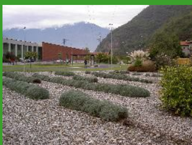
Bezirkskläranlage Meran Foto: Peter Risto
